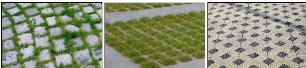
Ex. de traitement de sol limitant l'imperméabilisation
