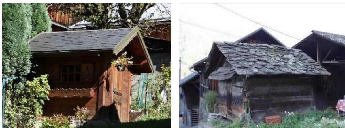
Photo 32 : Toit en ardoise (à gauche) et en lauze (à droite)
