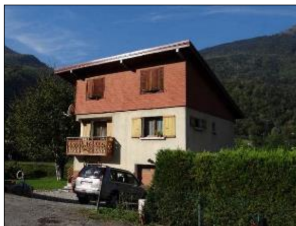
Photo 35 : Toiture à 1 pan
