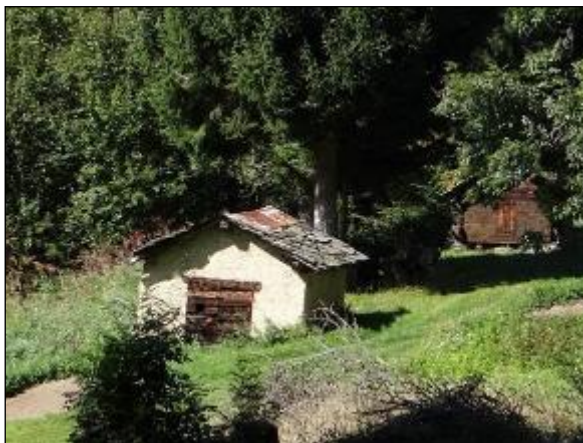
Photo 46 : Ancien local à pompe des pompiers au Bourgeois
