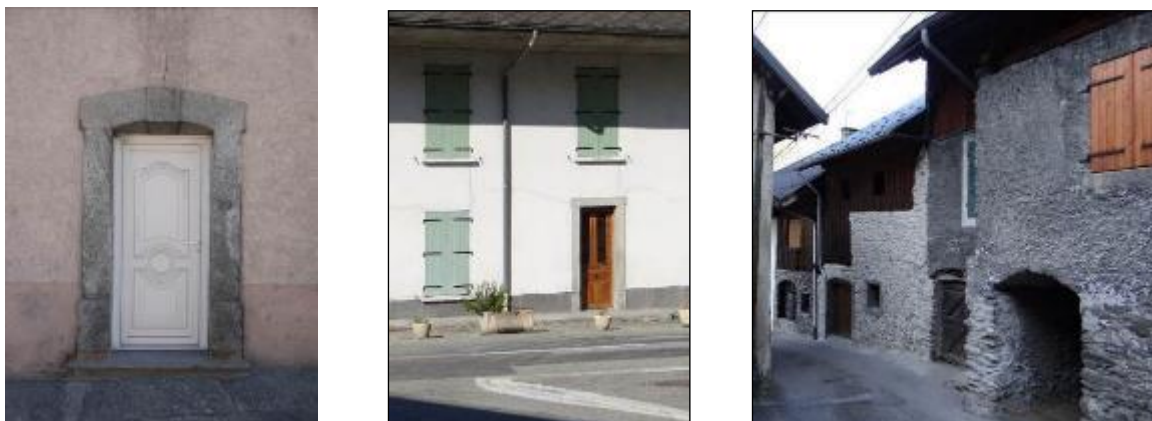
Photo 34 : Formes et encadrements d'ouvertures
