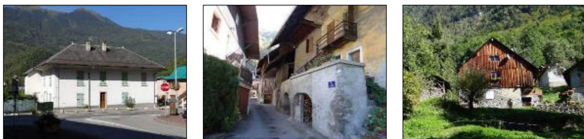
Photo 33 : Echantillon de façades
