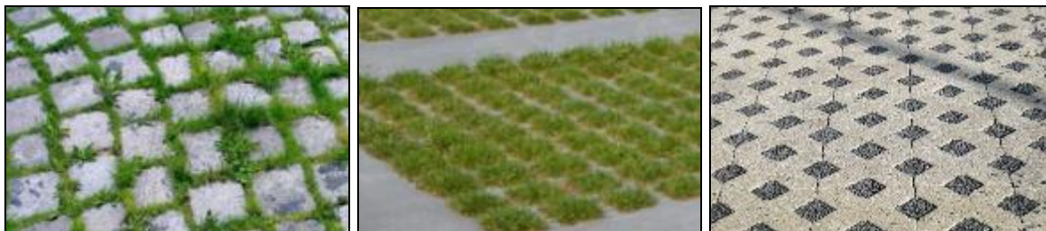
Ex. de traitement de sol limitant l'imperméabilisation
