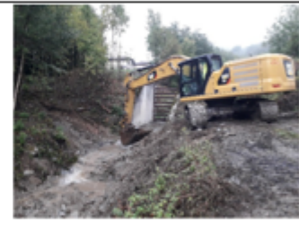
Confortement des seuils en aval de la plage de dépôt de la Gruvaz
