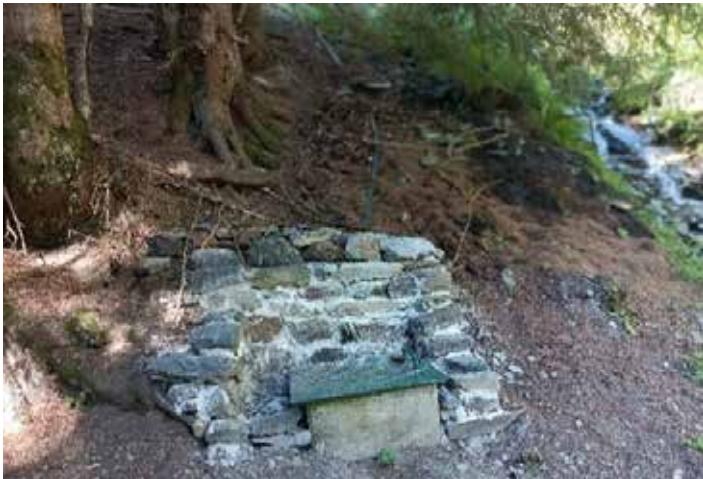
▲ Clôture autour de la cuve et protection de la chambre de vanne de Bénétant réalisée bénévolement en juillet 2022
